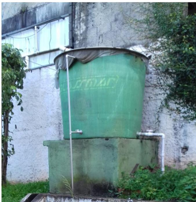
Figura 9. Reservatório de captação de água da chuva. Fonte: PMSP
